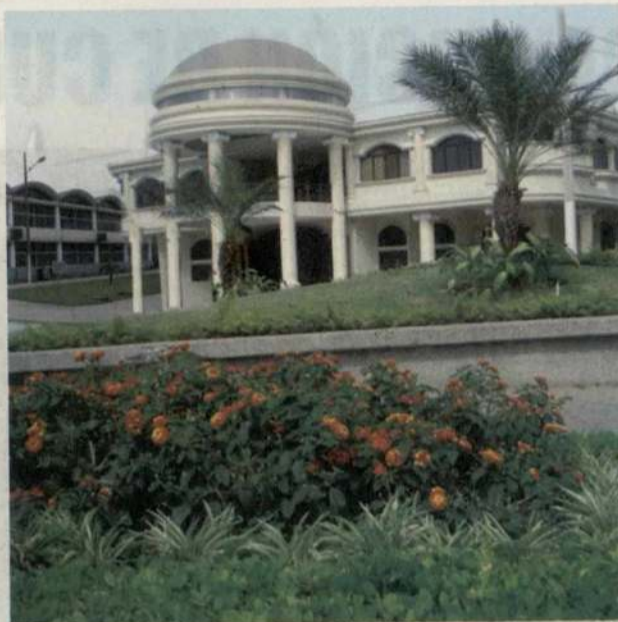
Edificio de la Administración central de la UAE, campus Guayaquil
