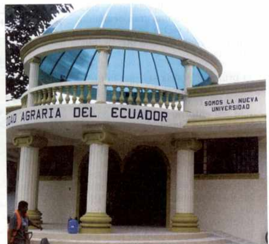
La Agraria construye edificios tipo, para laboratorios en los distintos Programas Regionales de Enseñanza, tal como se aprecia en la gráfica captada en el cantón Naranjal.
