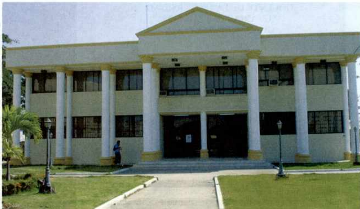
Imagen N° 3. Vista Frontal del SIPUAE Vista Frontal del SIPUAE donde se encuentran localizadas las aulas tipo, en la que se desarrolla parte del proceso de perfeccionamiento profesional.
