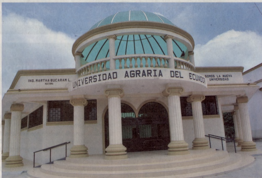
EDIFICIO TIPO LABORATORIO UBICADO EN EL PROGRAMA REGIONAL DE ENSEÑANZA DE LA UAE EN EL CANTÓN NARANJAL
